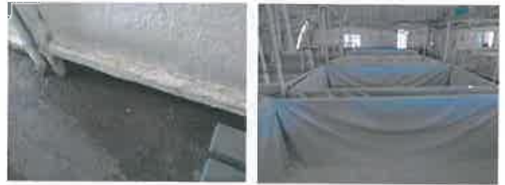
Trabajos de reparación en tinas de fibra de vidrio
