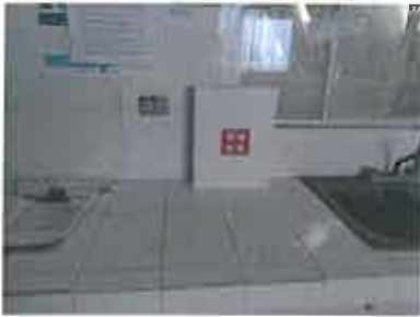
Instalación del botiquín de primeros auxilios
